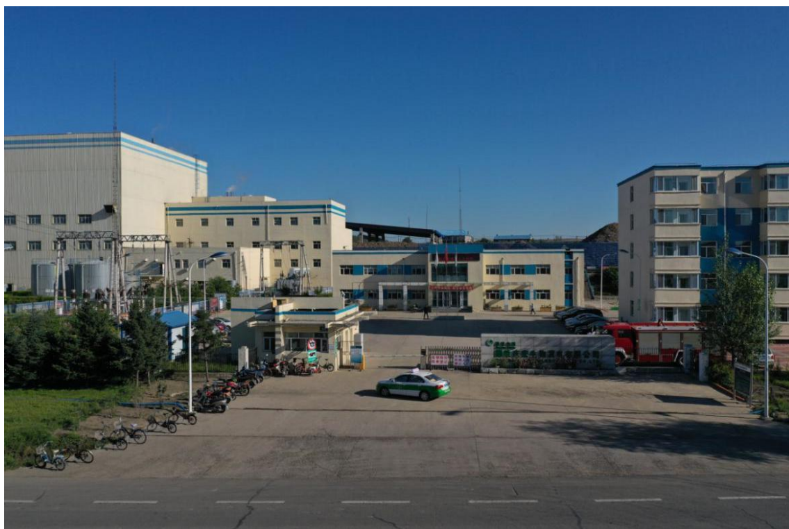
厂区南侧人员入口硬化（2020年8月无人机拍摄）
