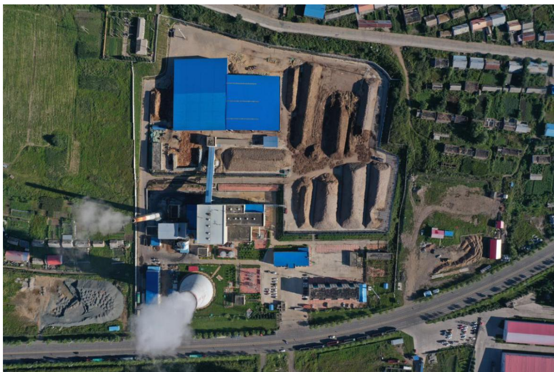
工程水土保持监测照片情况（2020年8月无人机俯视拍摄）
