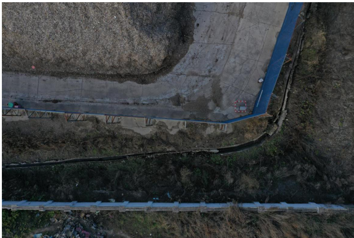
堆料场东北截排水沟及护坡绿化（2020年10月无人机拍摄）
