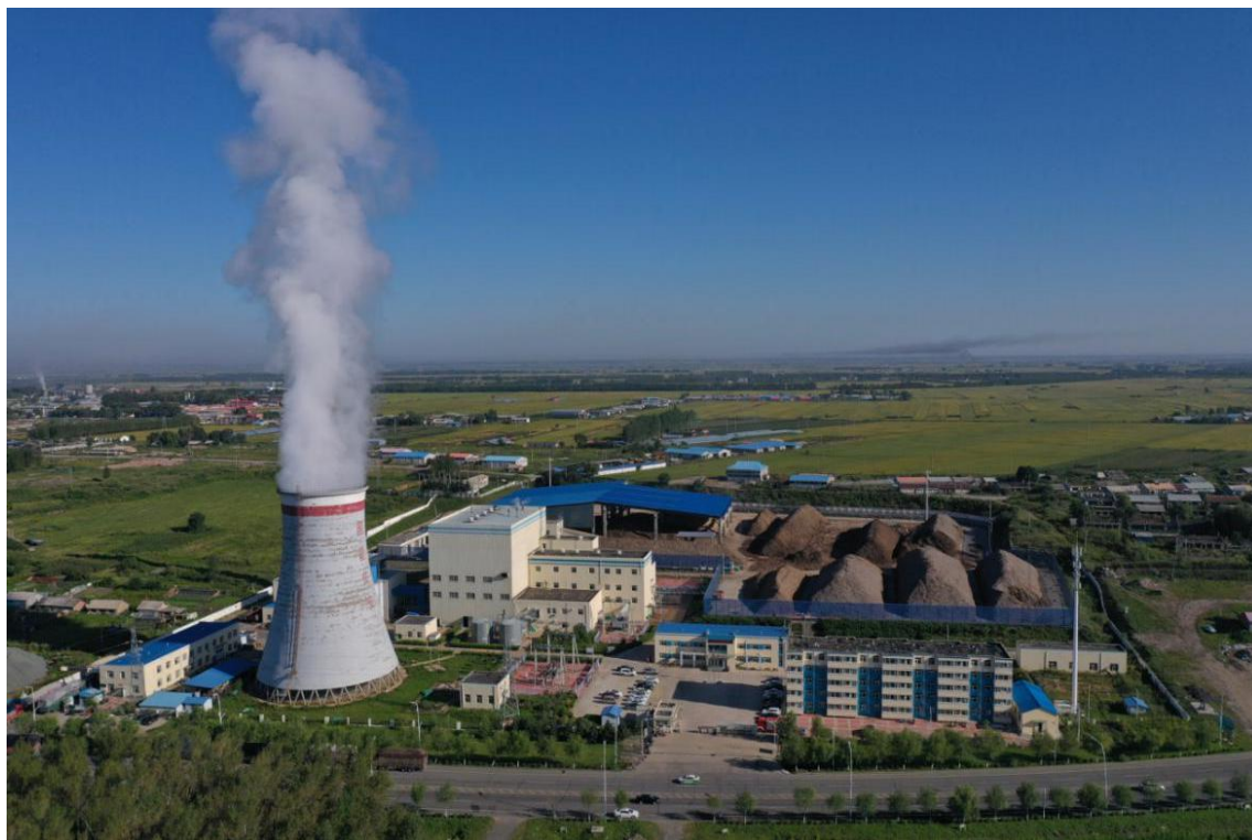
工程水土保持监测照片情况（2020年8月无人机自厂区南侧鸟瞰拍摄）
