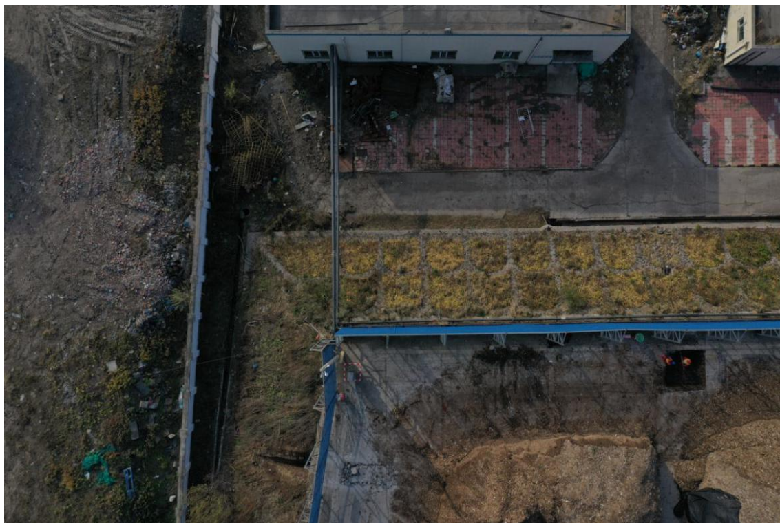
堆料场护坡绿化、坡底截排水水沟（2020年10月无人机拍摄）
