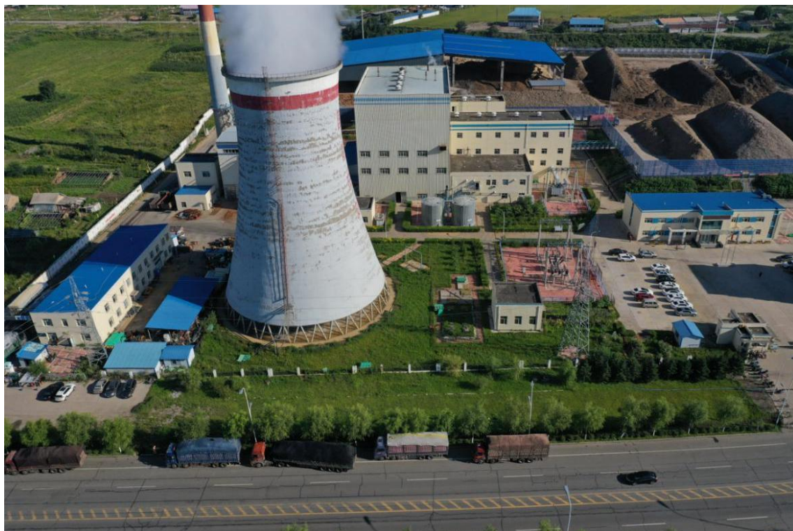
厂区西南冷却塔周边场地绿化（2020年8月无人机拍摄）
