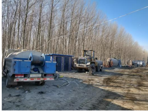
照片 1-2：工业广场现状
