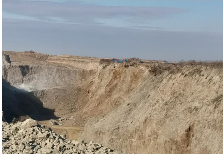
照片 3-1：采掘场边坡
