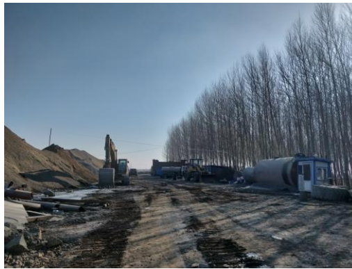
照片 1-5：矿区道路
