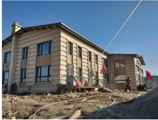
照片 1-4：临时构建筑物现状
